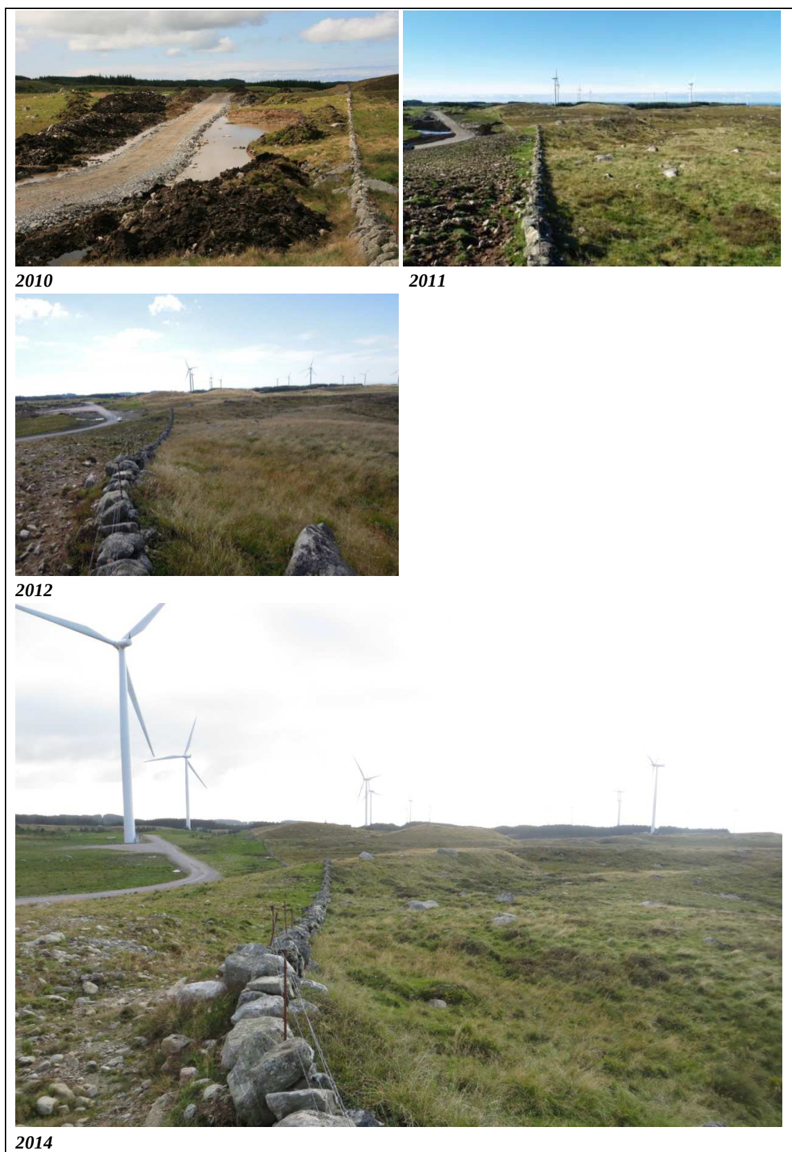
Figur 5.3. Utsikt fra fotopunkt 2 mot V. De to nærmeste turbinene, nr. 19 og 18, står i Time kommune og var blant de siste som kom i drift i 2012. De andre turbinene står i Hå kommune. Området til høyre for steingjerdet er ikke del av Høg-Jæren Energipark. 2010-fotoet er tatt nede ved svingen og mot turbin.
